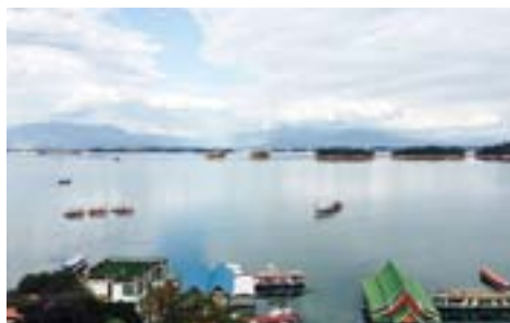
ナムグムダム湖 リゾート地 この電力でラオスをまかない→タイにも売電
