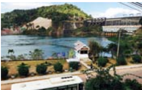
1971年に日本などの支援により完成したナムグムダム
